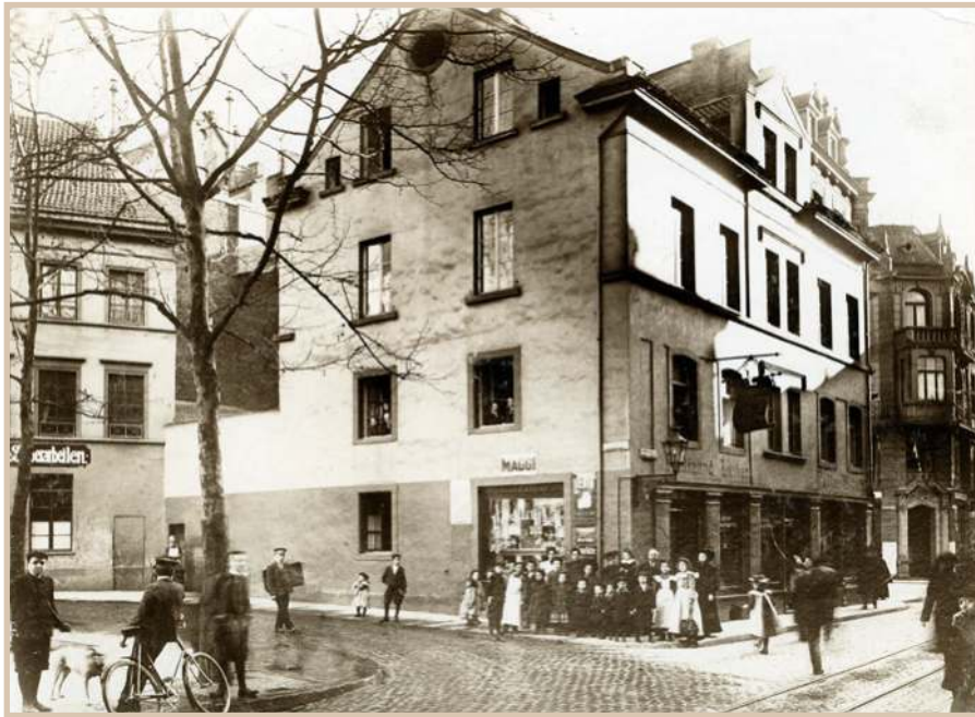
Haus Remigiusstraße 1, kurz vor 1770 als Pfarrhaus von St. Remigius erbaut, 1905 niedergelegt. Fotografie von Carl Schaaf, um 1900 (Stadtarchiv Bonn)
