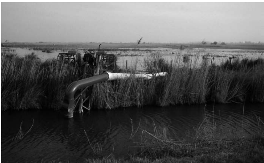
Photo 1. Irrigation d'un marais de chasse au moyen d'une pompe mobile, à partir d'un canal de drainage (crédit photo : Alain Dervieux).
