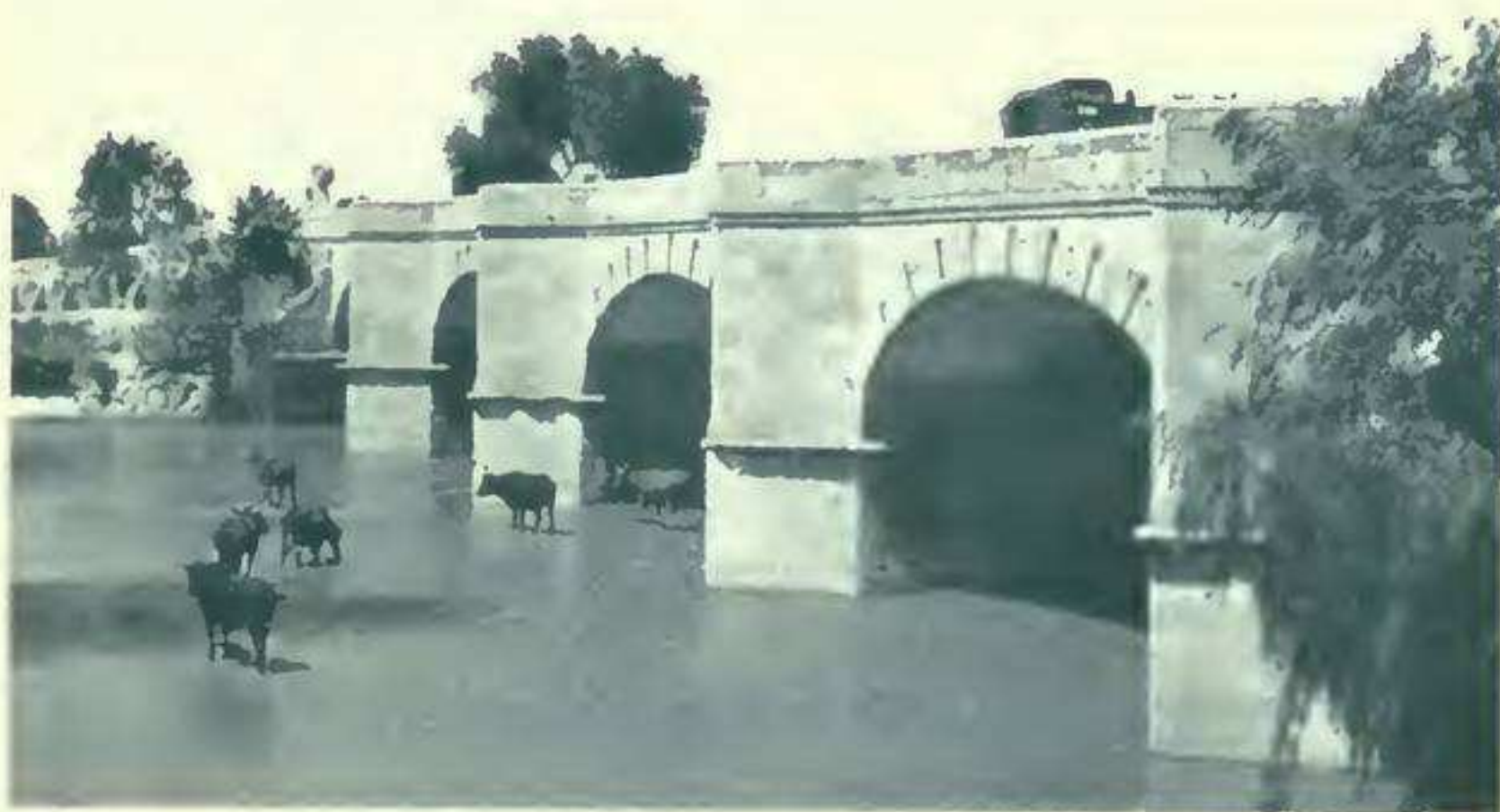
PUENTE DE LA LAJA, CELAYA. TRESGUERRAS, ARCHITECT.
