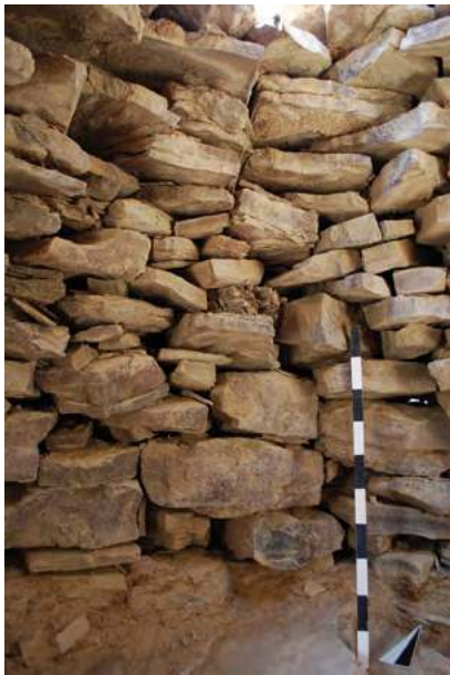
Abb. 218: Ringmauer des Grabes 07 von innen.
