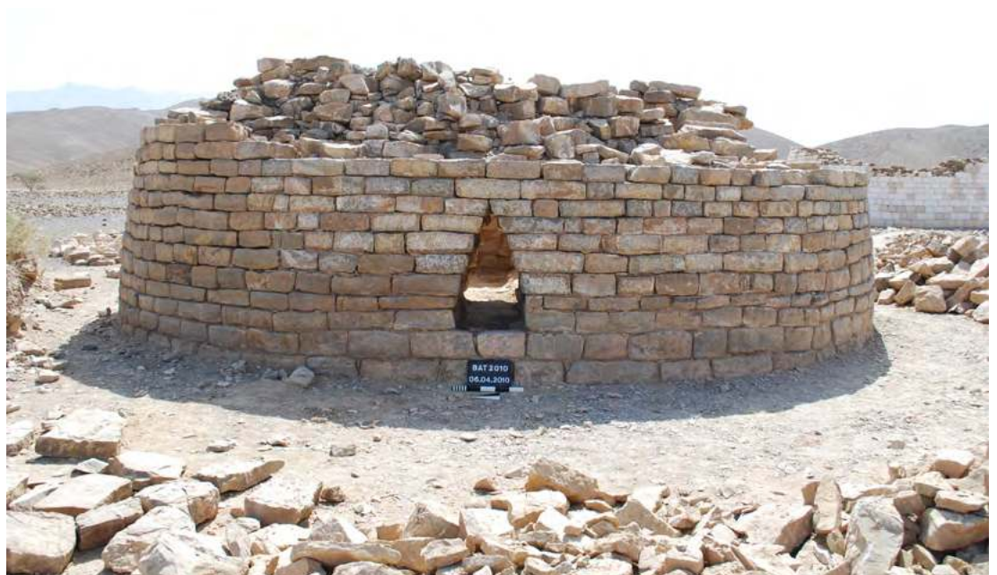
Abb. 92: Außenmauer A-Inst. 0002 des Grabes 156, teilweise neu aufgemauert.
