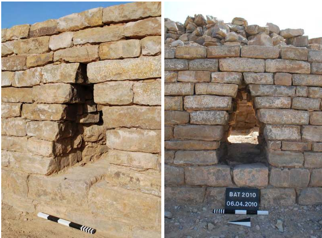
Abb. 89: Eingang A-Inst. 0001/Raum C (links) und Eingang A-Inst. 0004/Raum D (rechts), jeweils im oberen Abschnitt neu aufgemauert.
