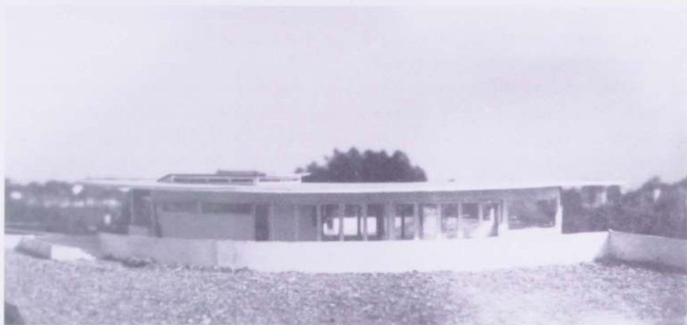
38. Jacques Groag, kleineres Betriebsgebäude (Funktion ungeklärt), um 1938
