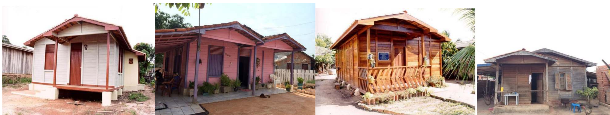
Figura 1. Imagens das construções em 2002 e atual, 2018.
